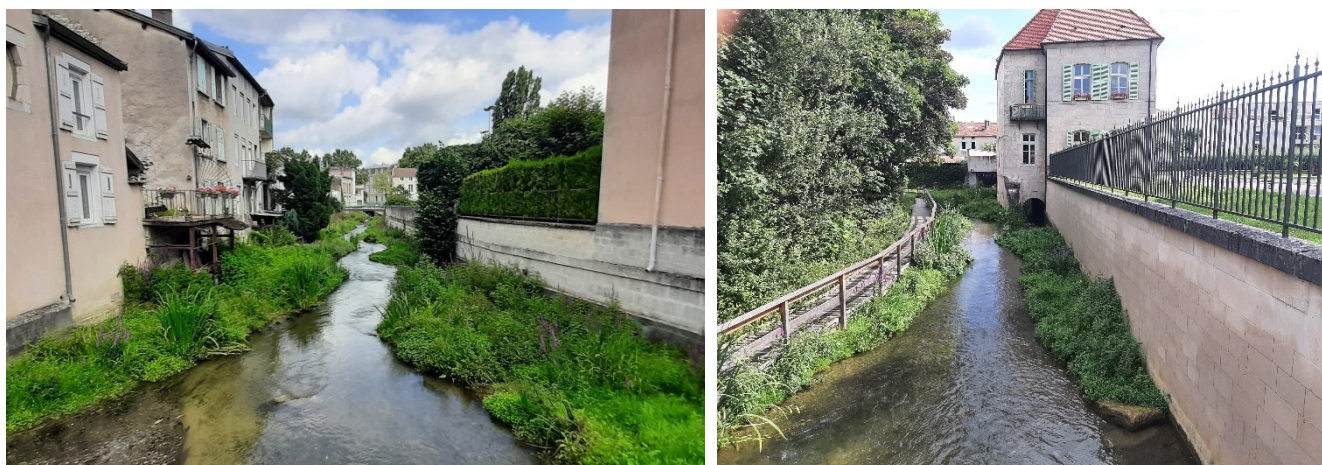
Figure 6 : Exemple de création d'un lit sinueux par mise en œuvre de banquettes « libres » végétalisées (source : Antea Group / IRH)
