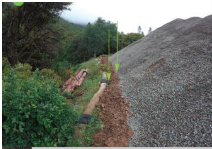
Figure 7 – Exemple de contrôle du périmètre à l'aide de copeaux de bois et d'un boudin de rétention
